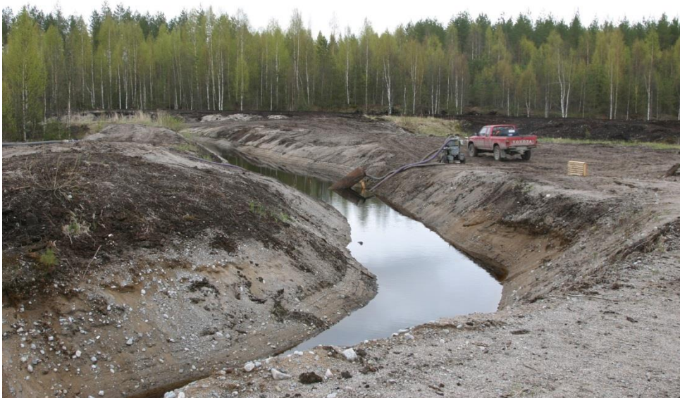
Kuva: Uusi ojalinjaus eristysoja- ja tuotantovesille Havusuo-pohjoisen kentältä. Alajuoksulla olevan pumppaamon kapasiteetin riittämättömyyden takia vettä pumpataan kuvassa näkyvällä pumpulla ojasta suoraan kosteikkokentälle.
